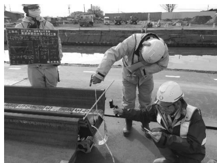
写真-1 ICT 機器を使用した遠隔確認状況 Remote confirmation using ICT
